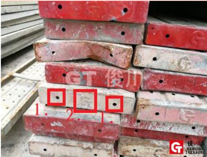
圖 31. 舊款有 2 個螺絲洞(圖 31.(1.)) 在板頭/尾刻有 GT 記號(31.(2.))
