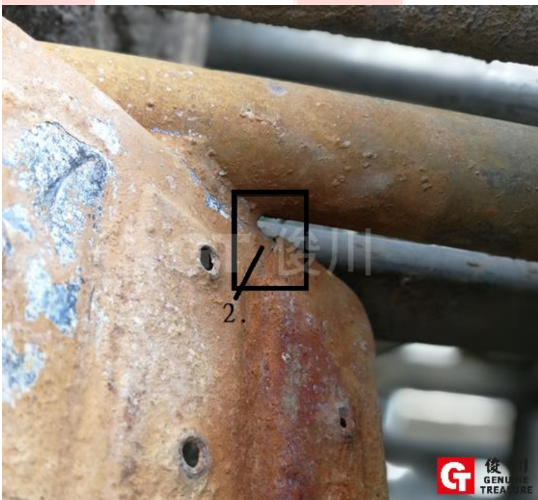
圖 86. 踏板邊緣龜裂或焊位斷裂 (86.(2.))
